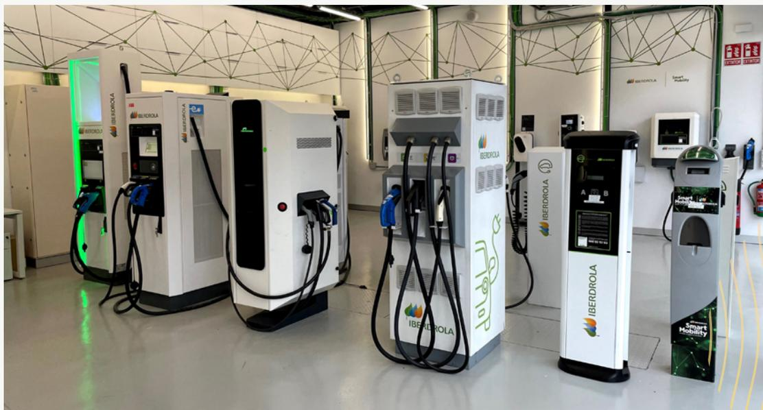
En Bilbao se sitúa nuestro laboratorio de movilidad eléctrica, dotado con las tecnologías de recarga más actuales del vehículo eléctrico. El laboratorio cuenta con cerca de 30 puntos de recarga (PDR) de distintas potencias, sirviendo, así como centro de pruebas para los fabricantes de los PDR y como apoyo al servicio postventa ya que investiga las incidencias encontradas en equipos operativos, replicándolos y dando soluciones en remoto.
