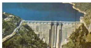
Puente Bibey - 7 M kWh
