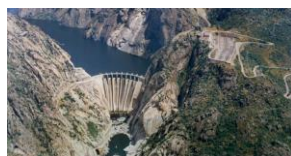
Aldeadávila II - 4 M kWh
