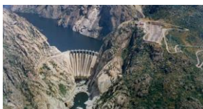
Aldeadávila II - 4 M kWh
