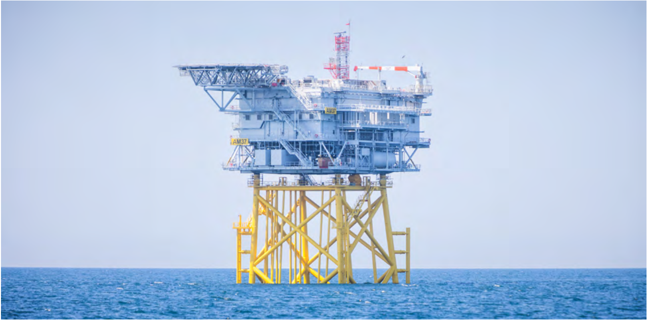
Parque eólico marino de Vineyard Wind - EE.UU.
