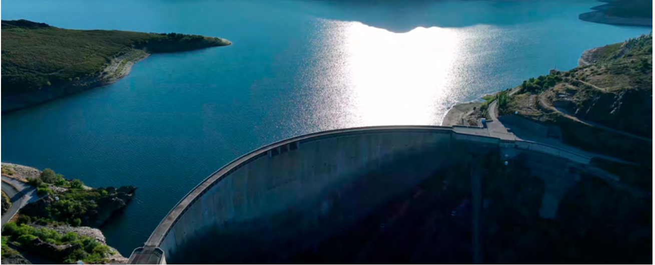
Central hidroeléctrica de Conso, Galicia, España
