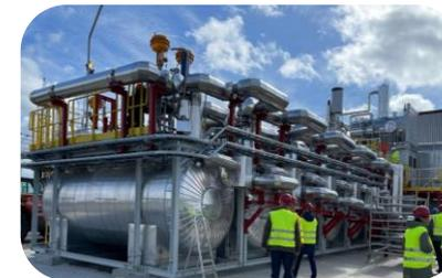
*Sistema de 4 MW / 18 MWh de almacenamiento térmico basado en sales fundidas en operación (Dinamarca)*
