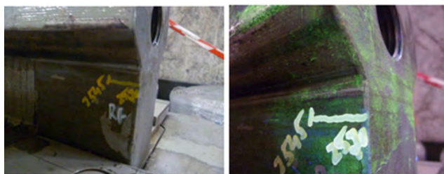
Trabajos en Polo 6 mediante Hand Yoke
