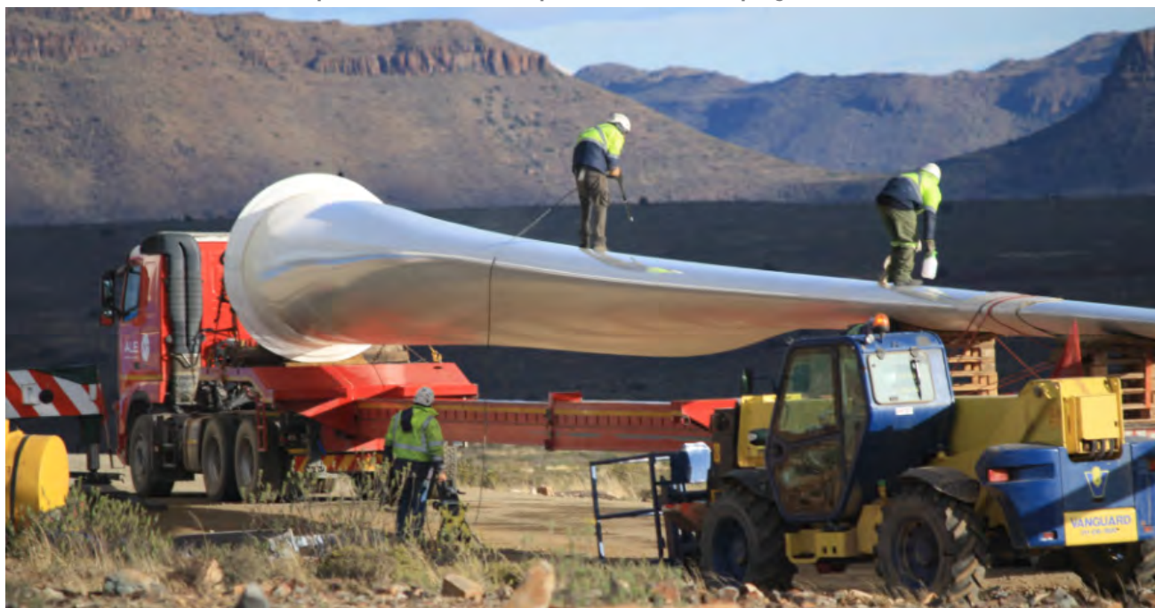
Trabajos de anclaje y transporte de las palas de los aerogeneradores
