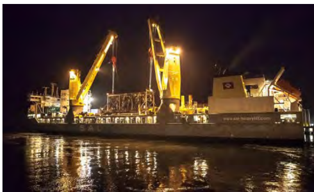
Campaña de prueba de pilotes parque eólico Wikingen
