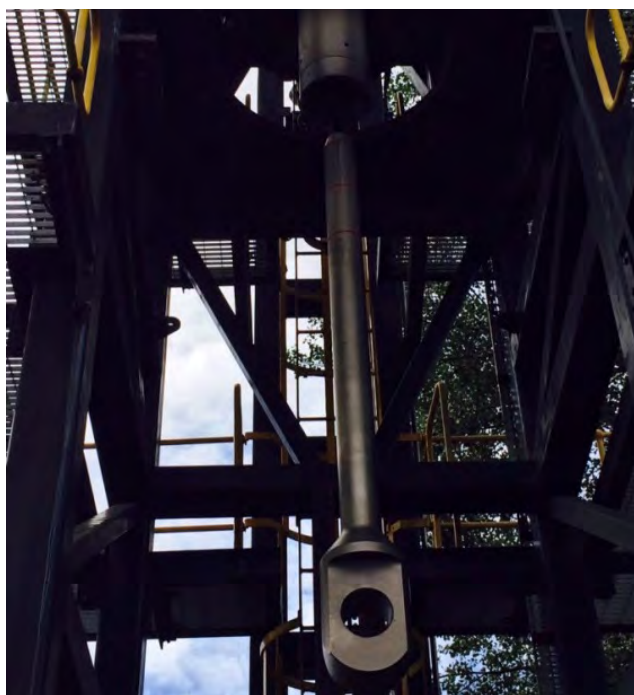
Instalación del sistema de fondeo
