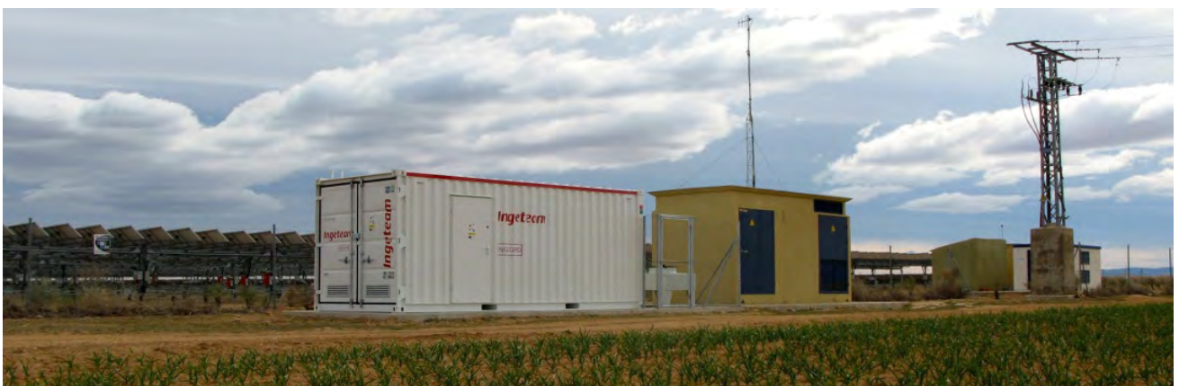
STATCOM MT (junto a huerto solar PV, La Herrera, Albacete)
