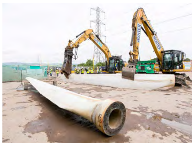
Proceso de sustitución de las palas de un aerogenerador
