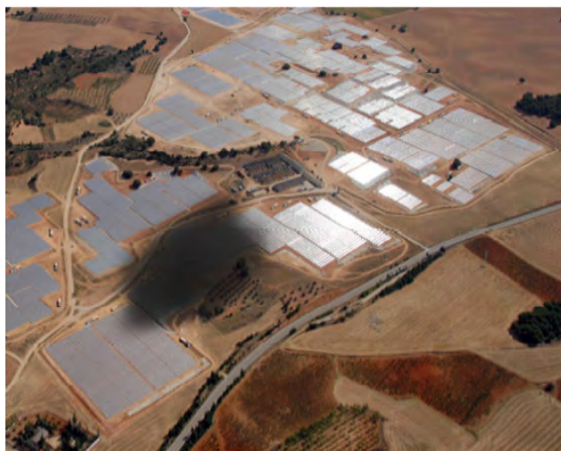
Almacenamiento aplicado a parques eólicos. (Fuente A123 Systems)
