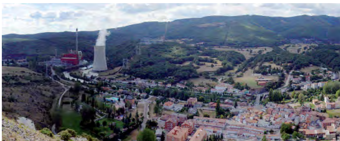
Central térmica de Velilla
