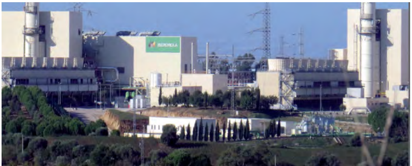
Central térmica de Arcos
