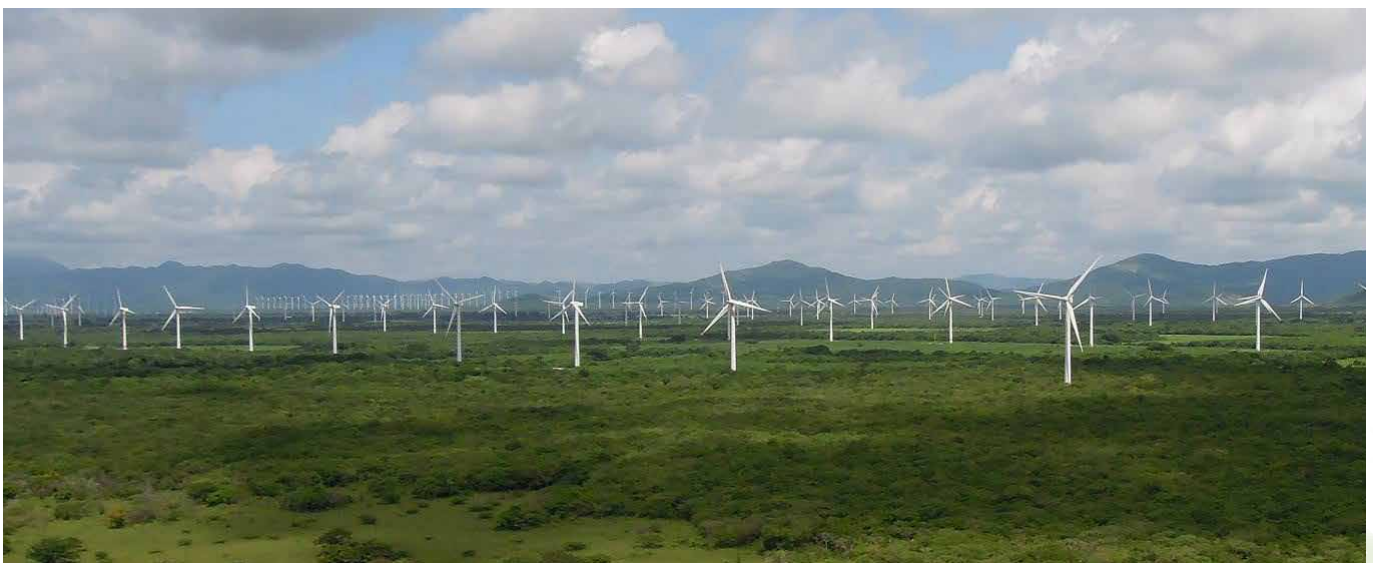
La Venta III Onshore Wind
