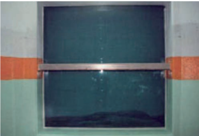
Detalle de la ventana de observación situada en el canal de salida
