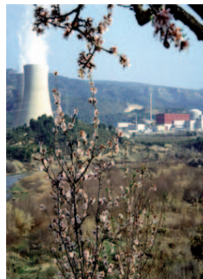
Cofrentes Nuclear Power Station (Valencia).
