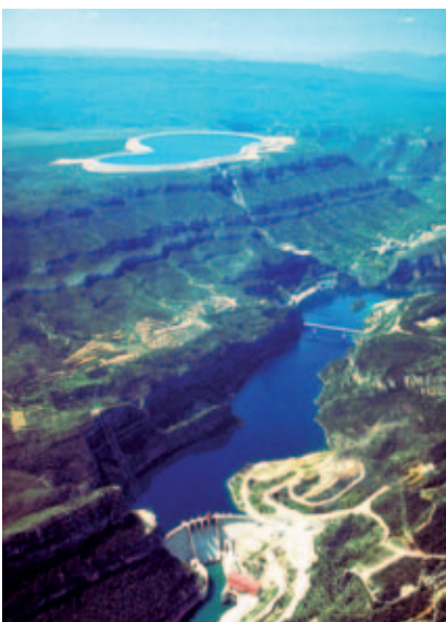
La Muela I - II Hydro Power Station (Valencia).
