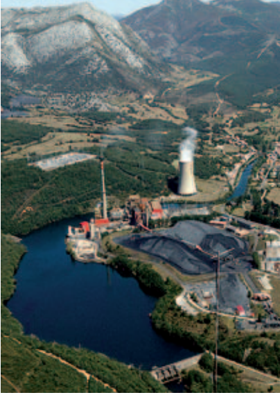
Velilla del Río Carrión Thermal Power Station (Palencia).
