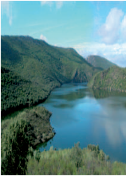
Alcantara dam (Cáceres).
