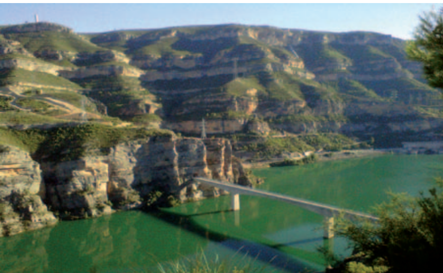
Cortes - La Muela Hydro Power Station (Valencia).
