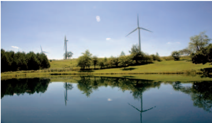
Casselman Windfarm (USA).
