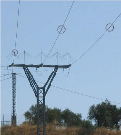
Elementos disuasorios de antiposada de tipo paraguas y anticollisión en línea eléctrica.
