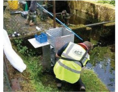
Figura 1: Construcción de trampa para anguilas.
