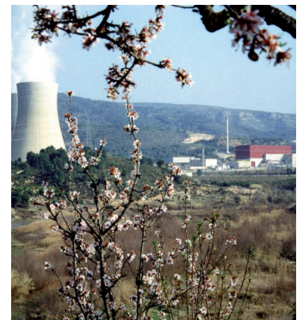
Cofrentes Nuclear Plant (Valencia)
