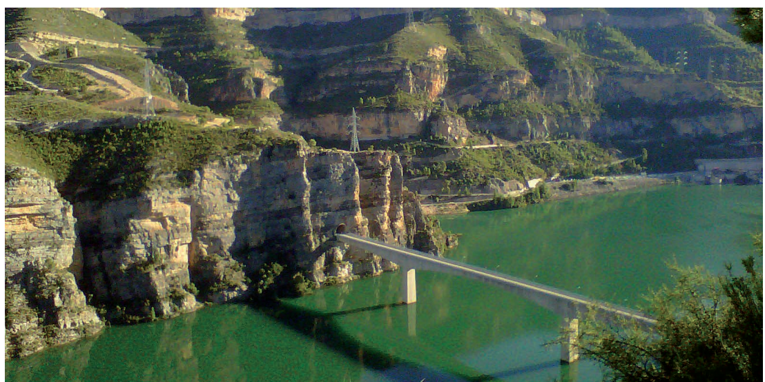
Cortes Hydroelectric Plant - La Muela (Valencia)
