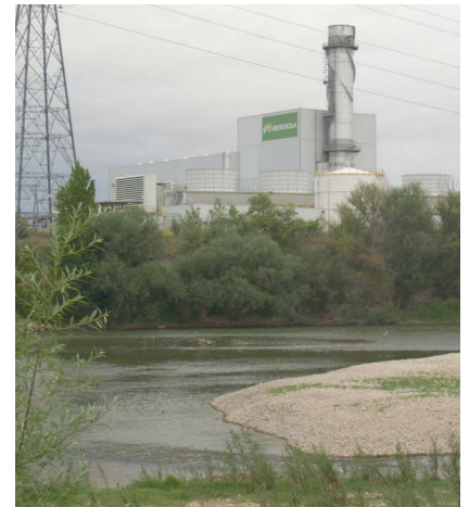
Castejón del Ebro Power Plant (Navarra)
