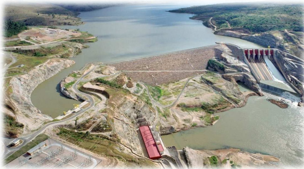
Instalación hidroeléctrica en Itapebí, Brasil
