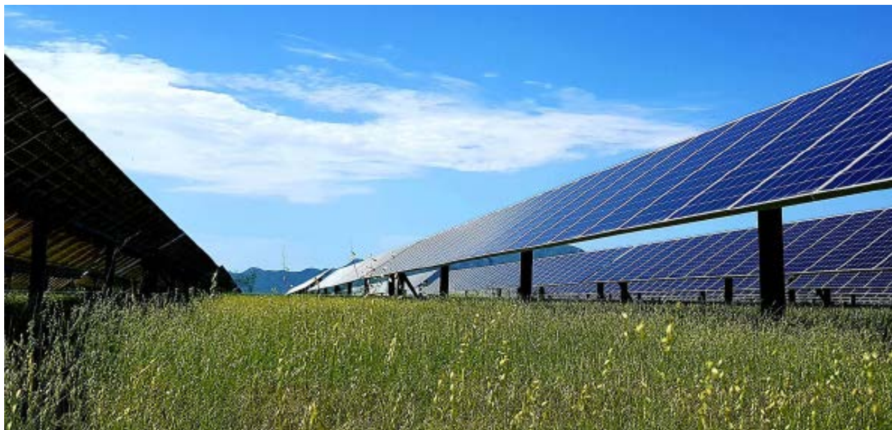
Central solar fotovoltaica de Hermosillo –Sonora, México
